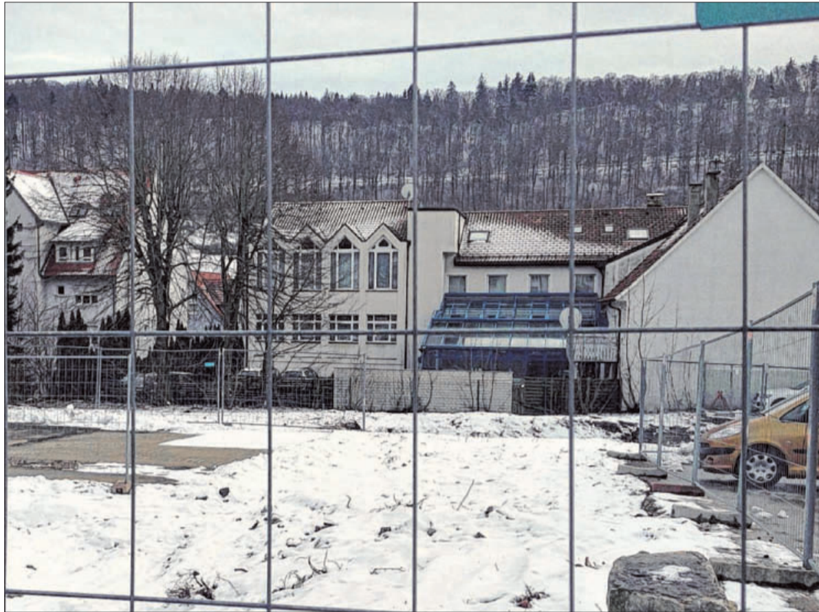
Beim Burladinger Rathausplatz wird der Bauplatz für das neue Ärztehaus vorbereitet.
